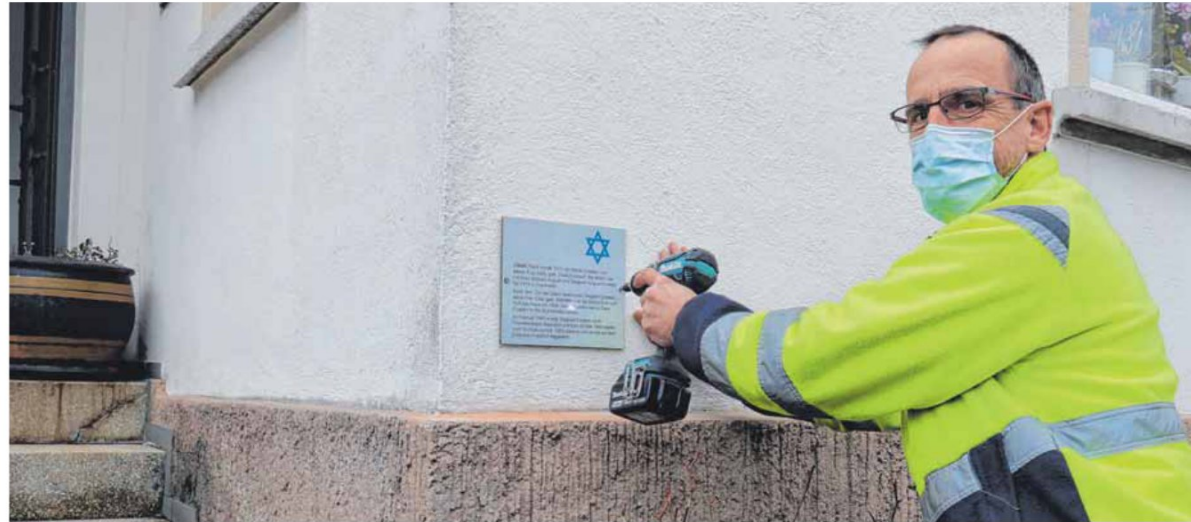
Bad Buchaus Bauhofleiter Jörg Schmid bringt die Gedenktafel an dem Haus an, das einst von Martin und Sally Einstein erbaut wurde.
